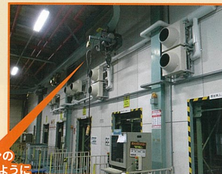
スポット・ゾーン空調システム FLEXAIR(単体設置型) オートフラップタイプ
